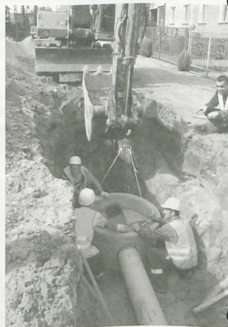
Budowa przy ul. 25 Stycznia
