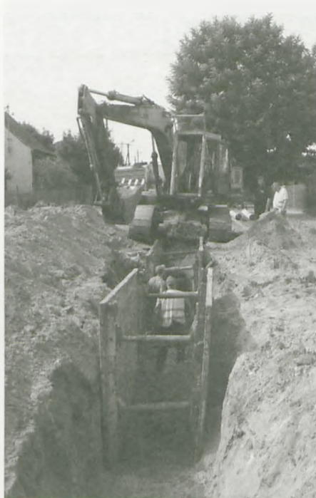
Budowa jezdni przy ul. Targowej
