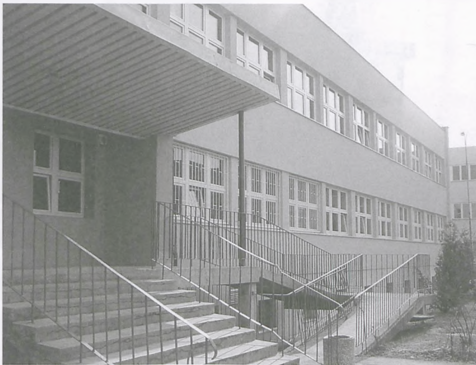
Budynek Zespołu Szkół w Bolechowie po termomodernizacji
