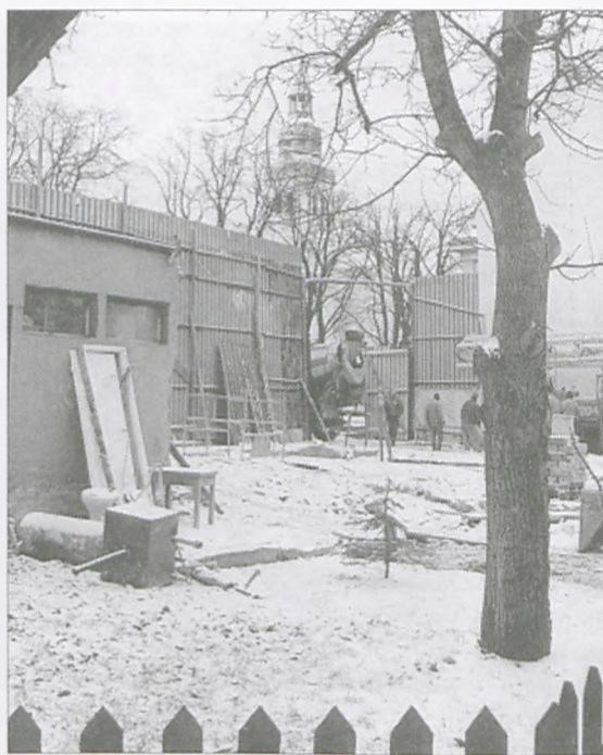
Kadr z początku lutego 2001 – po zburzeniu budynku trwa zalewanie fundamentów nowego domu
