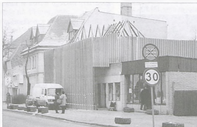
Styczeń 2001 – osłonięcie budynku metalowym ogrodzeniem
