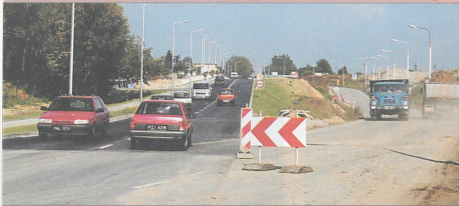
Ul. Żabikowska – w środę 26 września otwarto w Luboniu kolejny wiadukt, pod którym w przyszłości przebiegać będzie autostrada.
