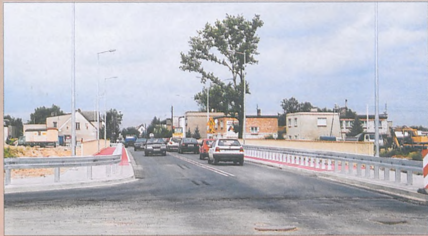
Wiadukt przy ul. Kościuszki włączono do ruchu w poniedziałek 6 sierpnia po południu. Zamknięto dotychczasowy objazd. Dojazd do ul. Niezłomnych możliwy jest teraz tylko od ul. Opolskiej w Poznaniu.
