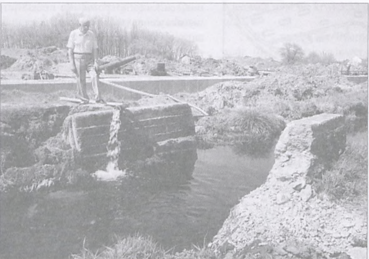
Dwa małe bloki betonowe usytuowane nad brzegami Strumienia Junikowskiego w pobliżu dawnego obozu żabikowskiego (widocznego w tylnym planie) są ostatnimi pozostałościami budowanej przez Niemców w czasie okupacji autostrady. W tym miejscu dokładnie na osi autostrady istniał w latach 1941-1943 mostek, po którym przejeżdżały pociągi wąskotorowe wożące ziemię z rejonu ul. Kościuszki w stronę ul. Zabikowskiej. Prace ziemne i pomocnicze wykonywali Żydzi, natomiast Niemcy obsługiwali koparkę i lokomotywki spalinowe.
