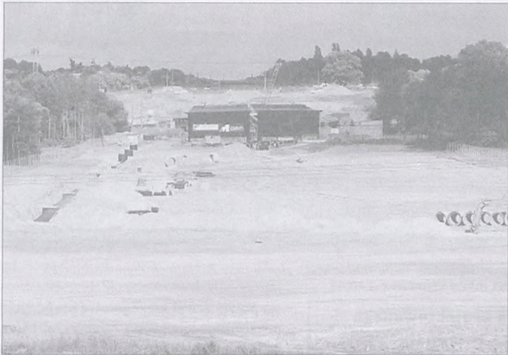
Widok z wiaduktu WD-6 w ul. Armii Poznań, w kierunku Starołęki - odległość 1300 m. Na pierwszym planie widzimy wyrównaną płaszczyznę, na której aktualnie układana jest kanalizacja wód opadowych. Oś przyszłej autostrady wyznaczają dwa równoległe mosty, każdy o szerokości 18 m. Za niewidoczną na zdjęciu Wartą wznosi się wysoki brzeg Starołęki.
