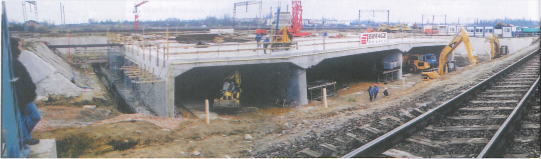
ryc. 4 Panorama placu budowy WK5 widziana z punktu B (wg ryc.1). Po lewej, zachodniej stronie widoczny jest blok stały, pośrodku para czynnych jeszcze torów kolejowych relacji Luboń – Staroleśka, następnie gotowy do przesuwu blok ruchomy oraz na prawym skraju pusty jeszcze taras widokowy.
