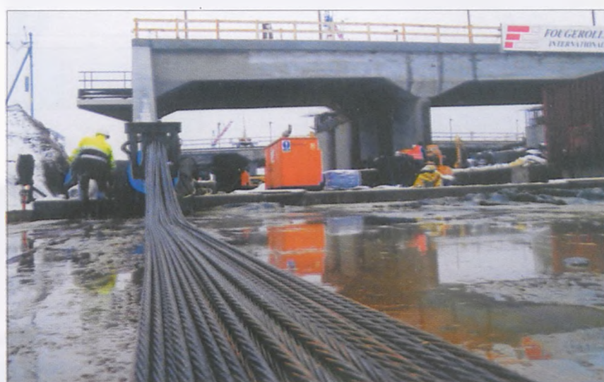
ryc.9 Nielicznym tylko udało się podczas samego przesuwu dostać tak blisko – bezpośrednio na płytę poślizgową. Na pierwszym planie wiązka jednej z czterech lin mechanizmów przesuwających blok tunelu przechodząca przez zespół siłownika. Na płycie poślizgowej widoczne resztki mazi poślizgowej zmieszanej z topniejącym śniegiem. W widocznych kontenerach zainstalowano systemy komputerowe sterujące i kontrolujące tę skomplikowaną operację.
