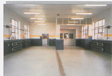
Hala lakierni - w głębi kabina bezpyłowa firmy GARMAT
