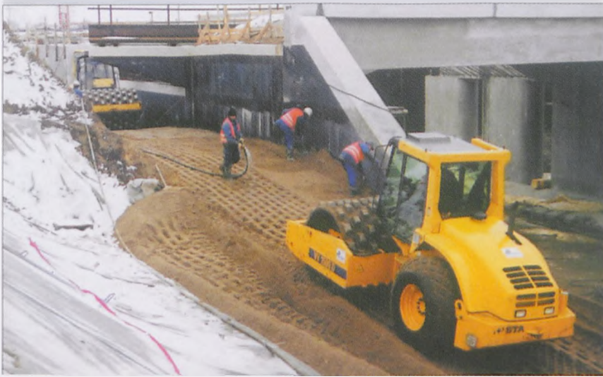
ryc. 14 Zасыpywanie szczelin pomiędzy nasypem kolejowym a blokiem. Gruboziarnisty żwir musi być dobrze zagęszczony. Po zapełnieniu szczeliny rozpoczęło się układanie torów kolejowych i połączenie z siecią PKP.
