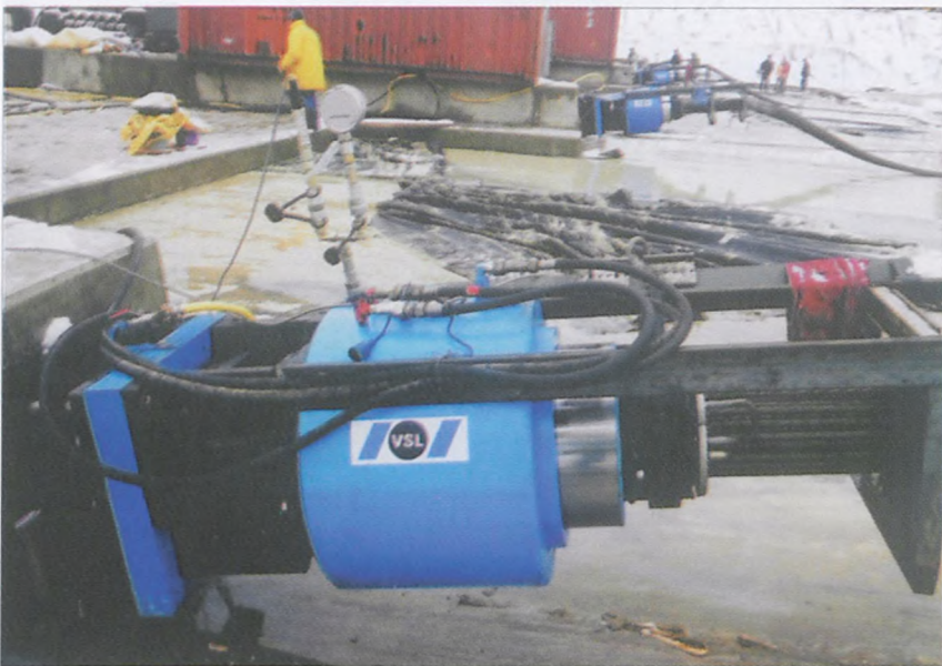
ryc.10 Tak wyglądał podczas pracy jeden z czterech sprawców przesuwu tunelu – zespół napędowy – silownik, zacisk i wiązka lin. W perspektywie widoczne pozostałe trzy silowniki.
