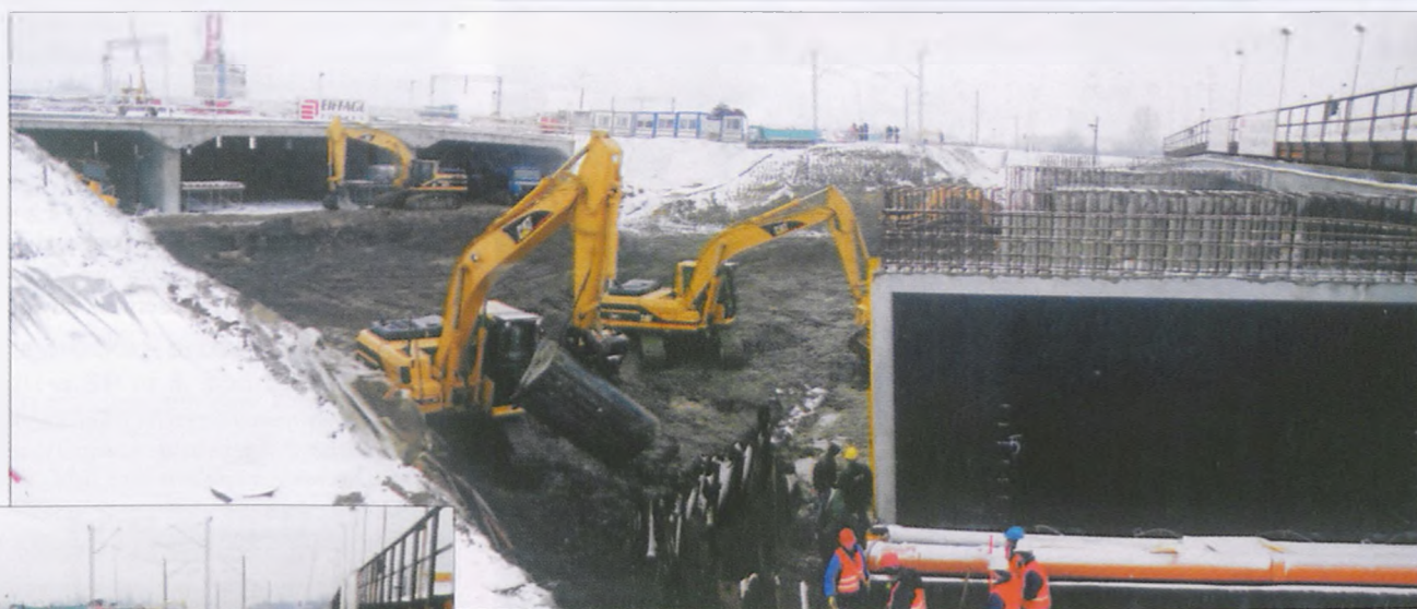
ryc.7 Po nocnej śnieżycy i przy silnym wietrze widzimy wielką przestrzeń po usuniętym nasypie. Lekkie koparki wyrównują jeszcze podłoże które musiało być niewzruszone przy likwidacji nasypu, a grupa robotników odcina palnikami ściankę grodziową. Niebawem padnie rozkaz „Włączyć silowniki!”.
