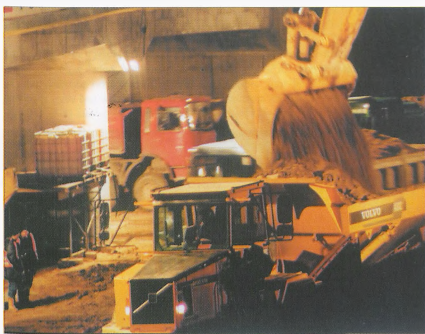
ryc.6 Nocne usuwanie nasypu. Załadunek 16-tonowej wywrotki trwał około 60 sekund. Takich stanowisk było cztery.
