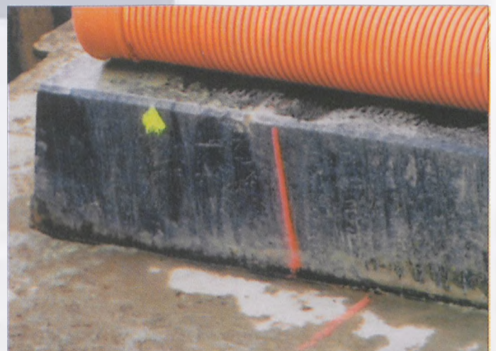
ryc.5 Po pierwszej udanej próbie przesuwu bloku około 30 cm. Widoczne dwie czerwone kreski wskazują wielkość przesunięcia. Teraz można dać sygnał do wstrzymania ruchu pociągów i rozpocząć demontaż torów.
