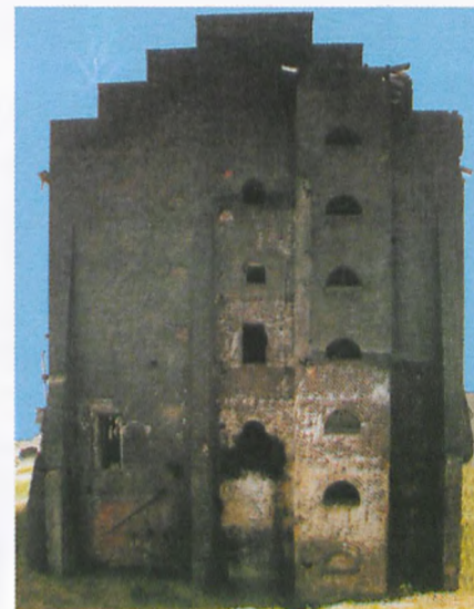
Zabytkowa kwasownia Zakładów Chemicznych wyleciała w powietrze!
