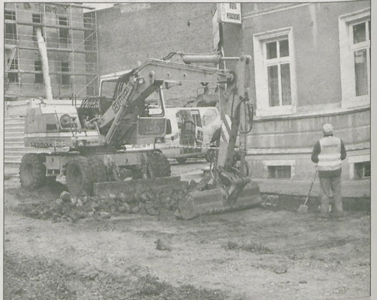
ROBOTY FIRMA KANBUD rozpoczęła w czwartek 5 lipca. Na przebudowanie ulic ma czas do 12 września
