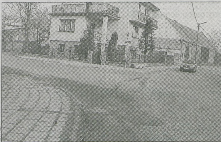
Szczególnie niebezpiecznie jest na skrzyżowaniu Zapłocia z Floriańską
