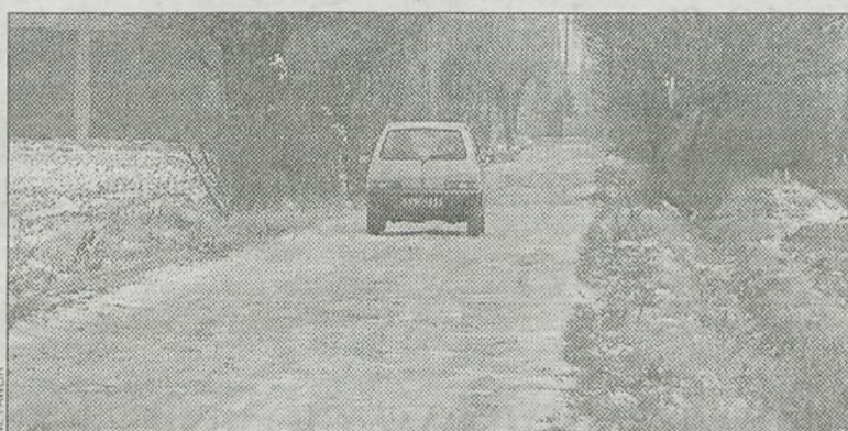
Już niedługo podziurawioną nawierzchnię zastąpi nowy asfalt
