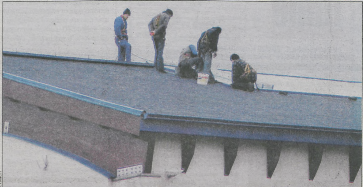
Piątkowy rano. Robotnicy naprawiają dach basenu
