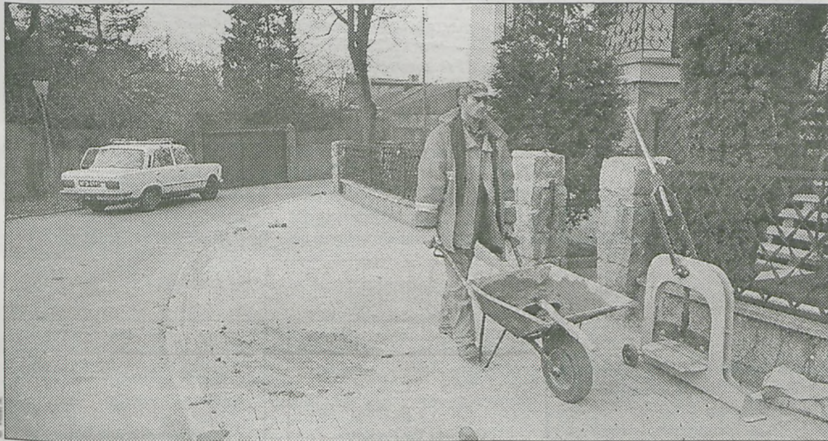
Kolo nowych chodników powstanie przejście dla pieszych
