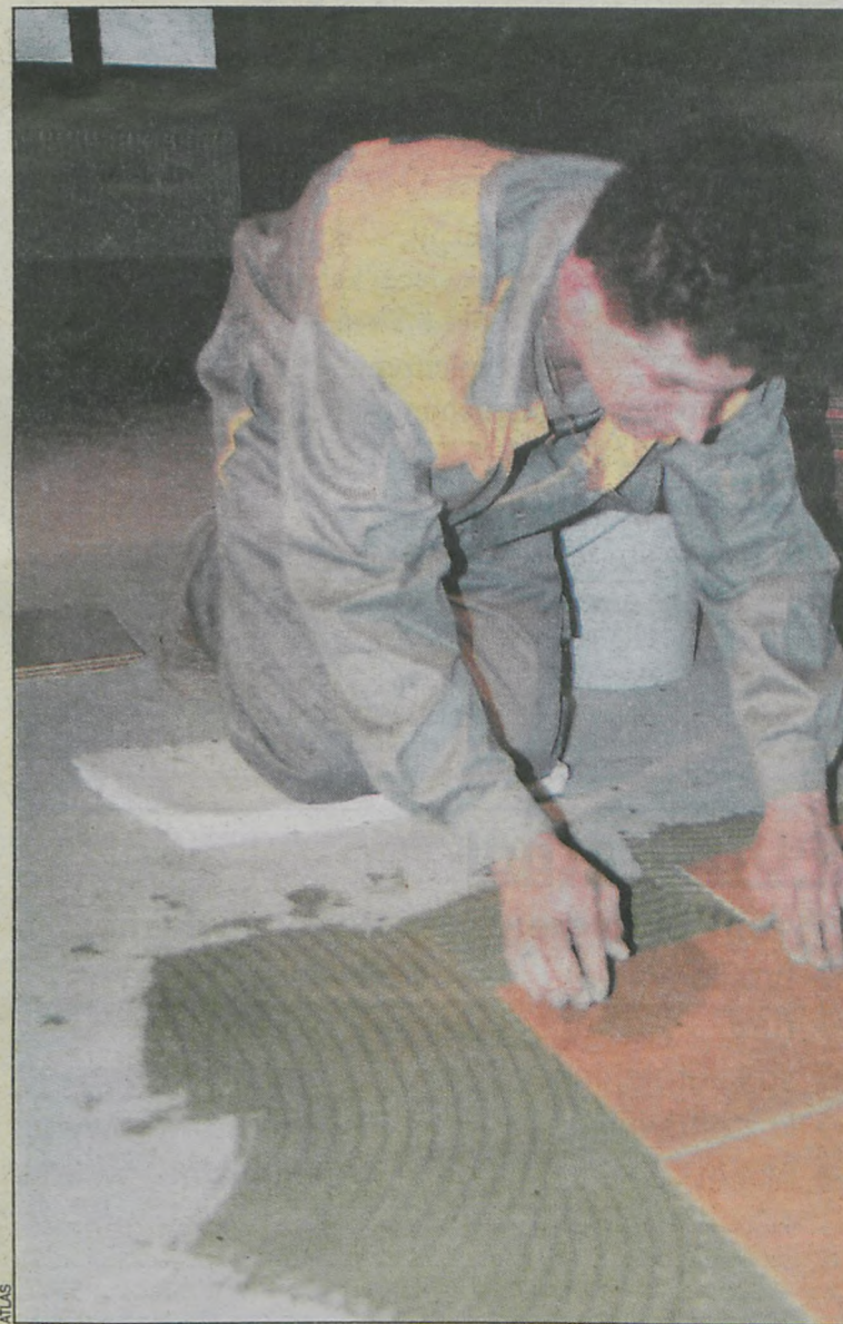
Szybkowiążąca zaprawa klejąca pozwala na użytkowanie okładziny już po 4 godzinach od przyklejenia płytek, dlatego doskonale sprawdza się przy układaniu gresu na klatce schodowej
