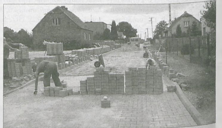
NAJPIERW WYKORYTOWANO TEREN na początku ulicy, po czym prace budowlane rozpoczęto z drugiej strony ulicy
