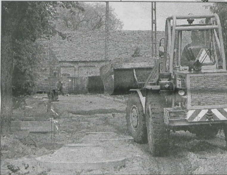
Przy sprzyjającej aurze prace zakończą się 31 maja
