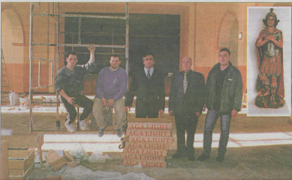
Remont sali Domu Strażaka na ukończeniu a figurka św. Florian powróci na fronton budynku
