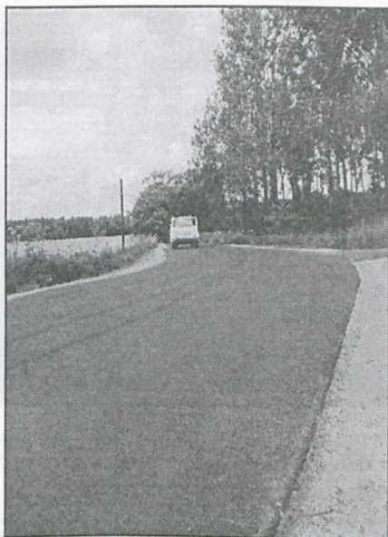
Tak pięknie prezentuje się nawierzchnia wyremontowanej drogi Babki — Głuszyna
