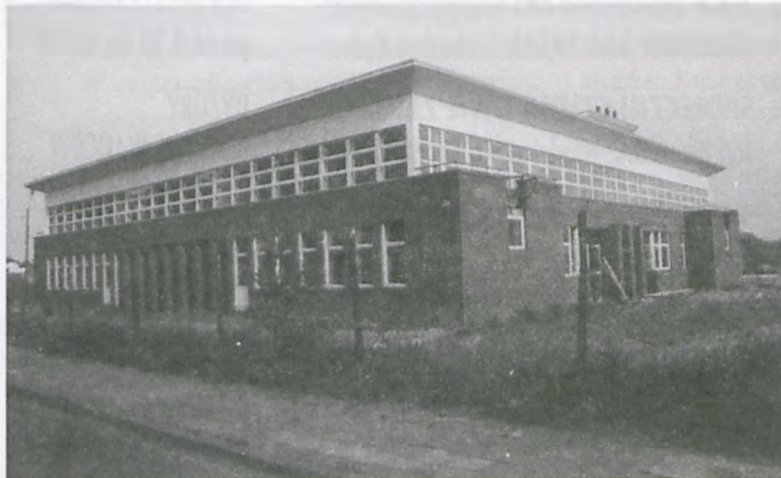
Budynek gimnazjum nr 1 w fazie prac wykończeniowych.
