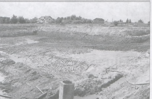
Zdj. 4. Wykop po zachodniej stronie torów Dębiec – Luboń (widok z nasypu kolejowego w kierunku ul. Rivoliego)
