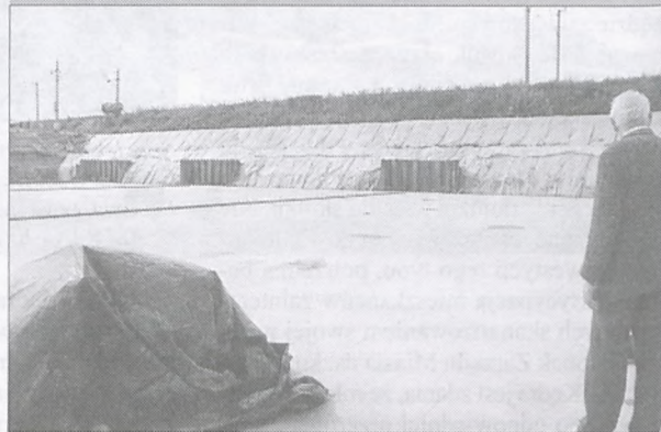
Zdj. 6. Oszlifowana płyta betonowa, po której na warstwie tłuszczu przemieszczać się będą maszyny do drażenia tunelu pod torami
