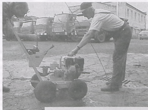
Najnowszy nabytek KOM-LUB-u walczy z zapchaną kanalizacją
