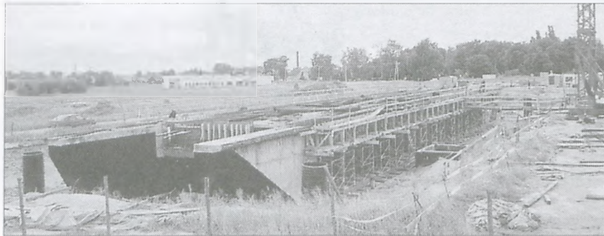
Zdj. 1. Wiadukt WD1 ul. Oplotki. Widok ogólny od strony północnej w kierunku cmentarza żabikowskiego widocznego w tle jako grupa drzew
