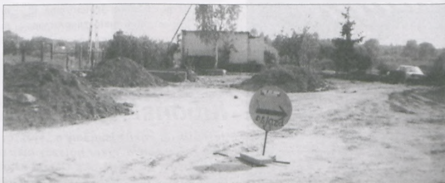
Widok działki otoczonej placem budowy od strony Poznania
