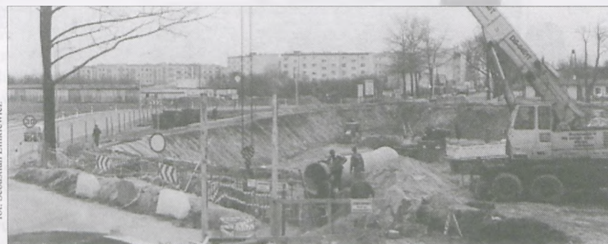
Plac budowy wiaduktu przy ul. Kościuszki. Ściany ogromnego wykopu dziś pokryte są folią w celu zabezpieczenia przed osypywaniem.
