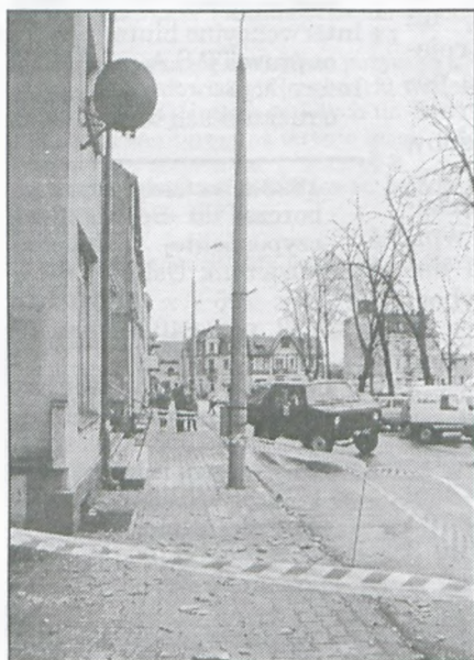
Na mosiński rynek poleciały dachówki. Służby porządkowe zabezpieczyły teren błyskawicznie
