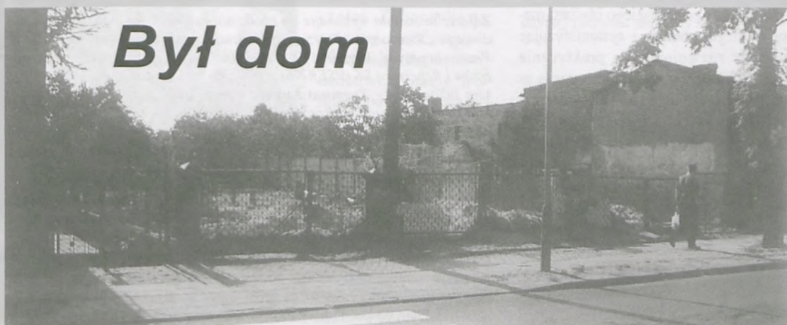
Miejsce, które pozostało po rozebraniu domu przy ul. Kościuszki 58 (pisaaliśmy o tym w ubiegłym miesiącu). Na skutek podkopania fundamentów budynek pękł tak nieszczęśliwie, że nadawał się tylko do rozbioru.
