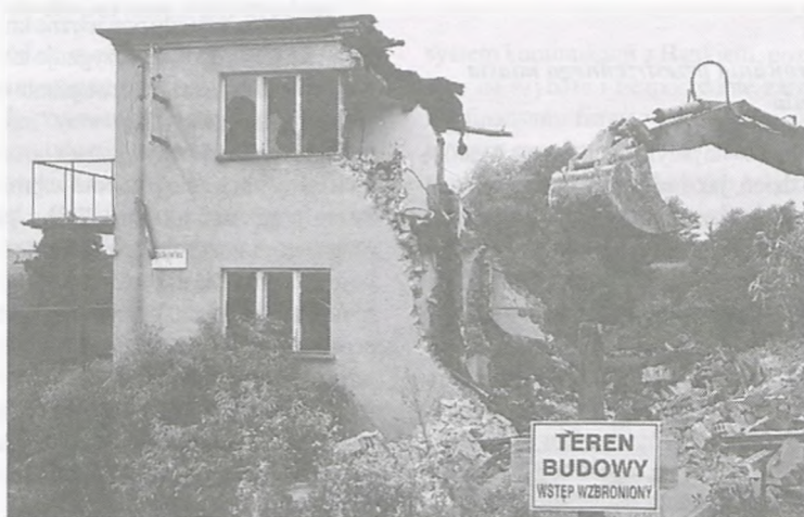
Od tego domu rozpoczęto wyburzanie budynków pod wiadukt przy ul. Żabikowskiej
