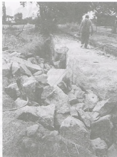
Kruszone z wielkim trudem bloki fundamentów poniemieckich
