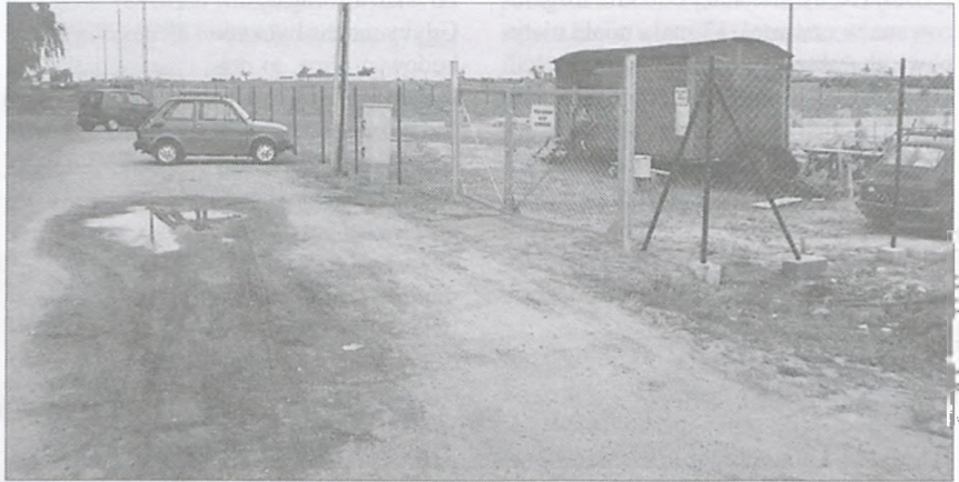
Plac budowy firmy RODAN przy ul. Cmentarnej – teren naprzeciw lubońskiej nekropolii
