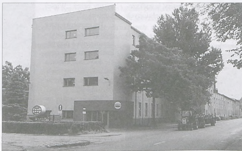
Wielkopolskie Przedsiębiorstwo Przemysłu Ziemniaczanego – widok od strony wejścia głównego
