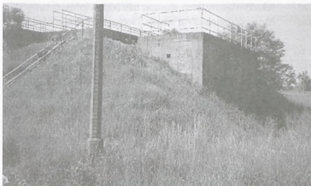
Fragment oczyszczalni. Widok zbiorników, których krawędzie zabezpieczają jedynie łatwe do pokonania barierki. Ten z prawej – pusty – głęboki na kilka metrów.
