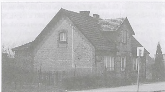
Pierwszy z domów przeznaczonych do wyburzenia przy ul. Kościuszki (za skrzyżowaniem z ul. Poniatowskiego). Na jego poddaszu dotąd mieszkają pp. Dehmelowie
