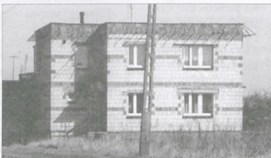
Przeznaczony do wyburzenia dom sprzed 9 lat (dobudówka) przy ul. Granicznej
