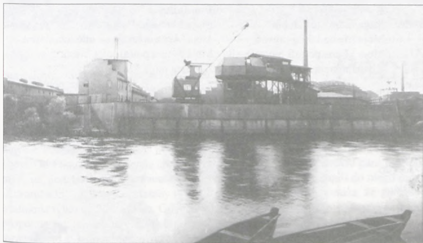
Port Zakładów Chemicznych - widok od str. Czapur - okres przedwojenny
