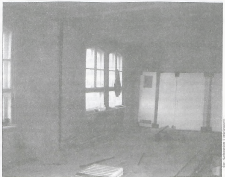
Tak wyglądają remontowane sale lekcyjne
