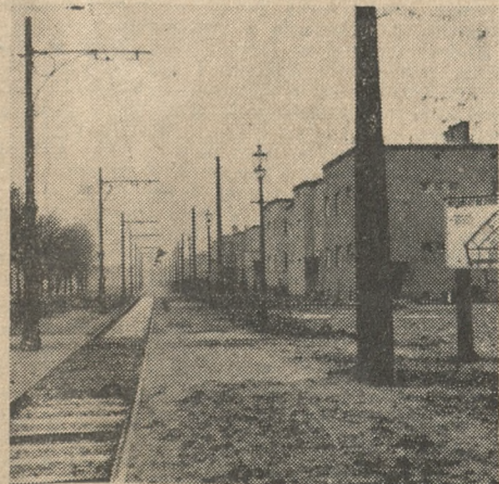
Nowa linia tramwajowa do osiedla przy ul. Grunwaldzkiej
