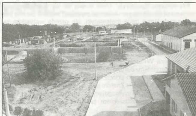
Widok placu budowy oczyszczalni
