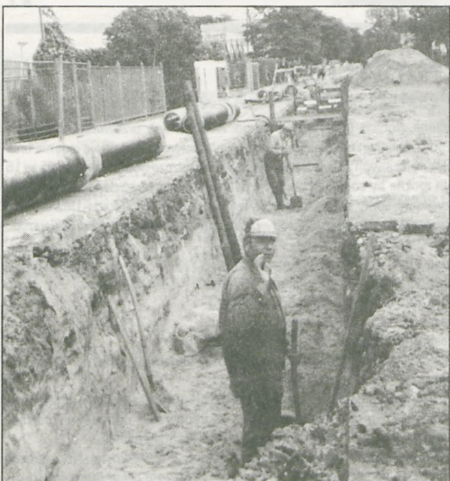
Budowa szczegółowej sieci kanalizacyjnej.
