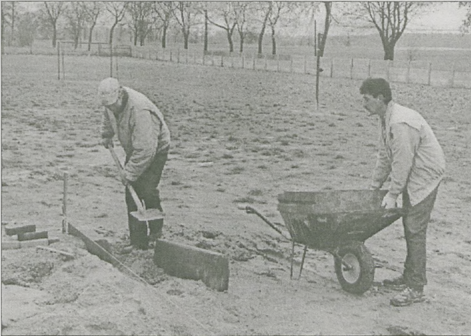
Panowie z Zakładu Gospodarki Komunalnej w Tulizkowie kończą prace przy placu apelowym
