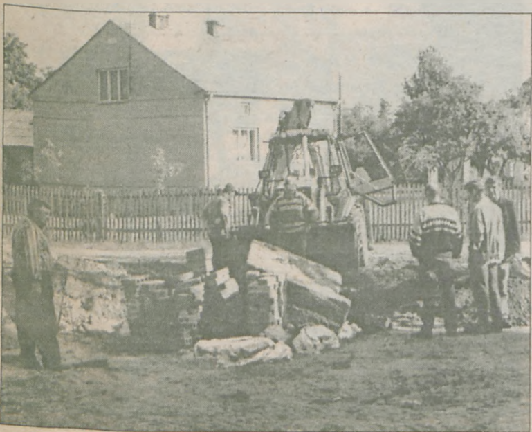
Mieszkańcy Przykonu przyglądali się postępowi prac
