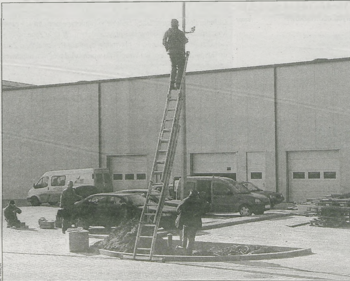
Trwają prace wykończeniowe
