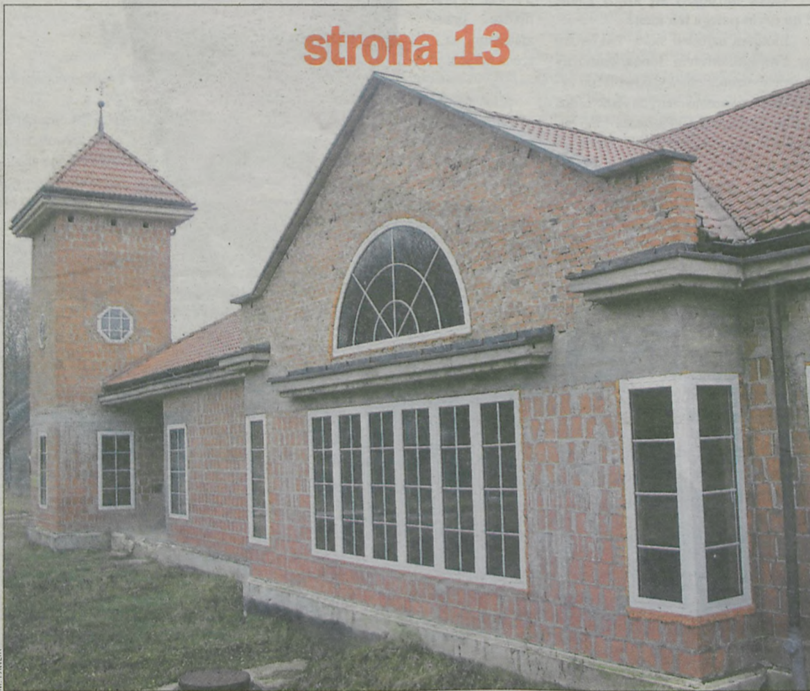
Jakkolwiek Najwyższa Izba Kontroli wykazała nieprawidłowości w procedurach przetargowych dotyczących rozbudowy domu pomocy w Baszkowie, uznała, że inwestycję koniecznie trzeba dokończyć (zdjęcie sprzed roku)
