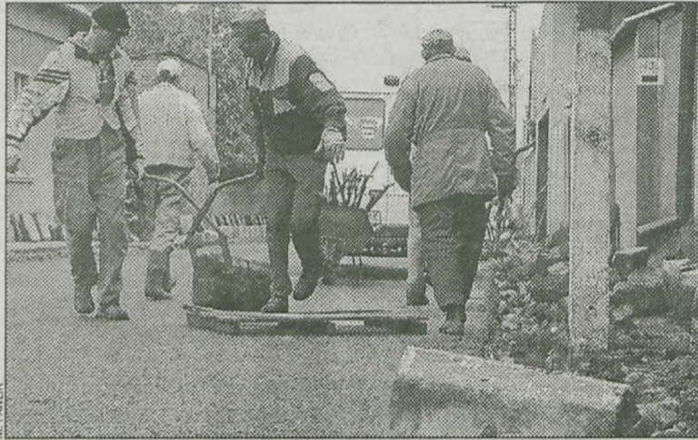
To dopiero początek prac na tej ulicy
