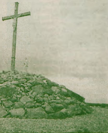
Przy budowie Golgoty pracowali wszyscy mieszkańcy wsi
