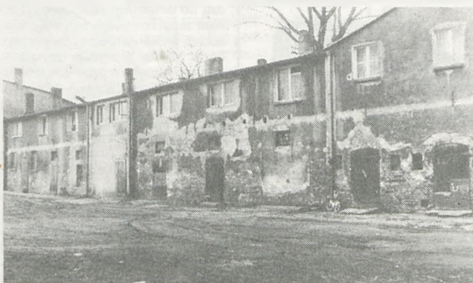
Budynek komunalny przy ulicy Źródlanej
