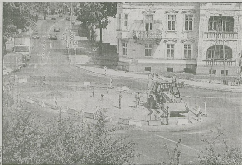
Już wkrótce nie będzie można tędy przejechać
