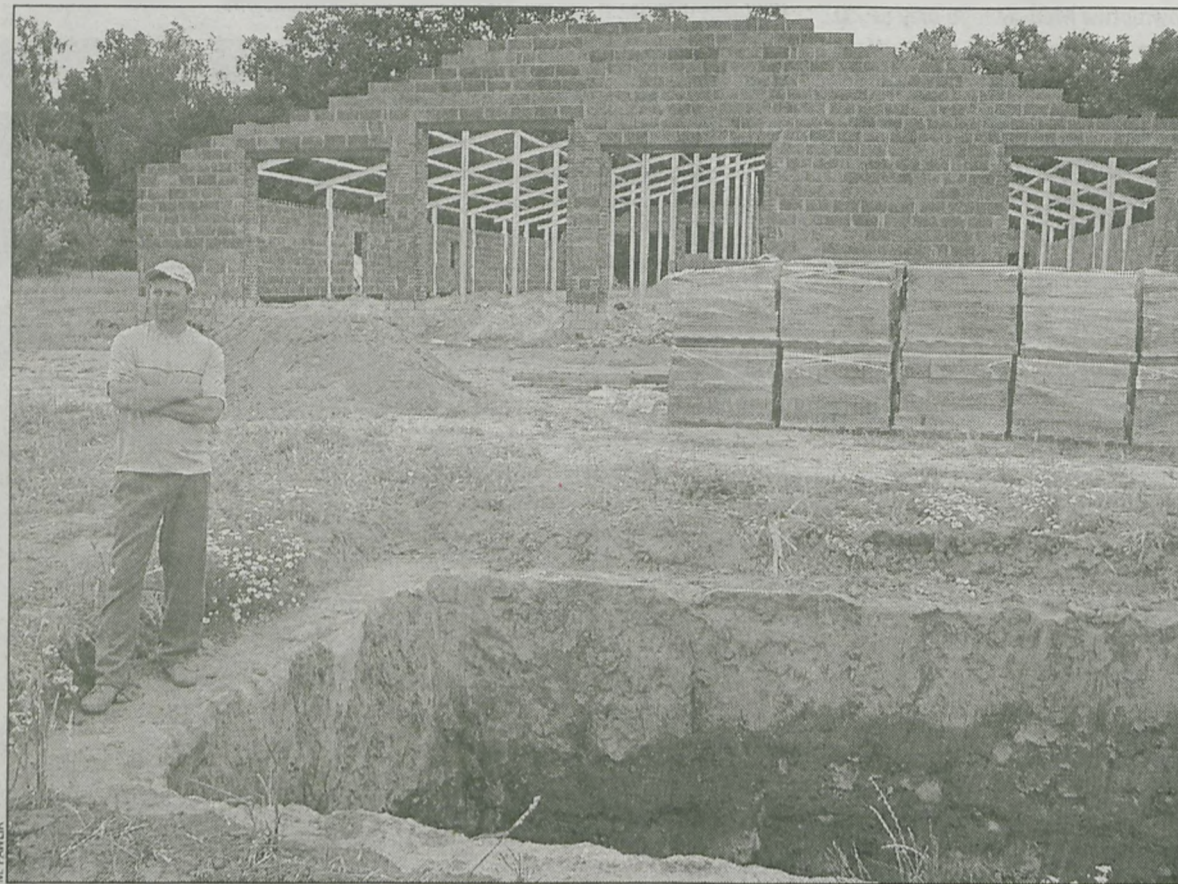
W tym miejscu będzie nowy zbiornik na gnojowicę
