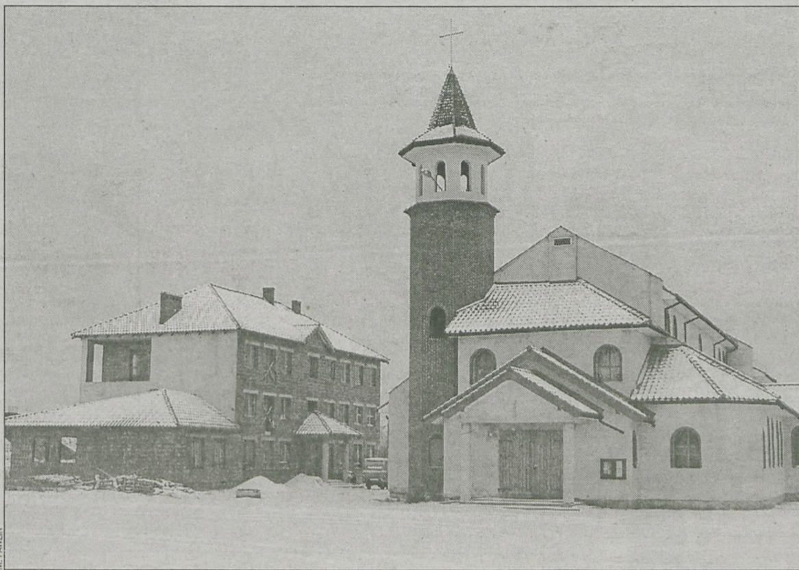
Budowa kościoła i domu parafialnego rozpoczęła się w 1997 roku
