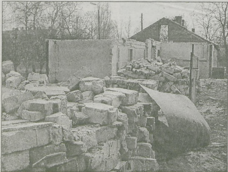
PKP, aby płacić mniejszy podatek, wyburzyły część swoich budynków
