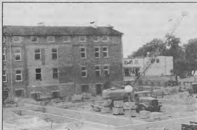
Prace przy budowie sali już trwają
