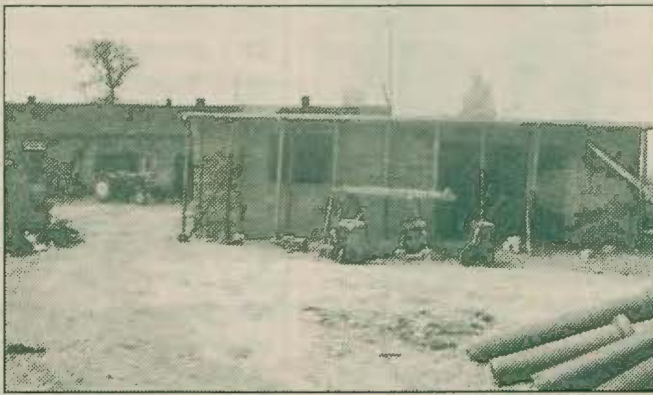
Taki był stan budowy domu na początku maja
