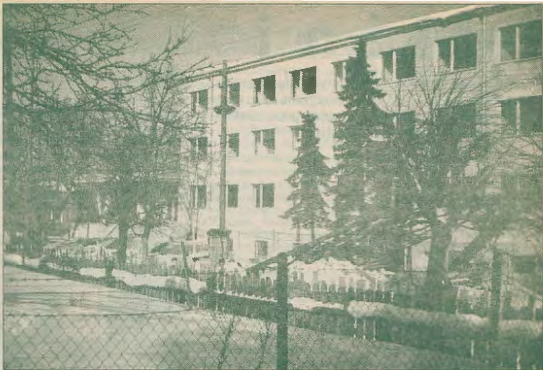
1959 r. Gmach Szkoły Podstawowej nr 2 w budowie. Fot. S. Jafra
