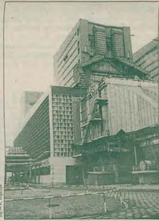
Jeden z pięciu bloków 120 MW w Elektrowni „Adamów”
