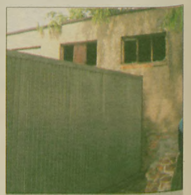
DO KOTŁOWNI przylega jeden z garaży. Mieszkańcy chcieliby by na miejscu kotłowni powstały kolejne garaże
