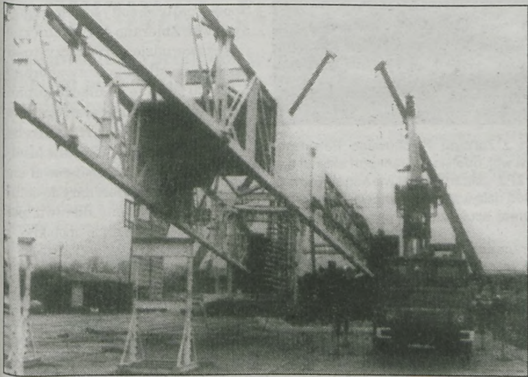
Montaż ponad pięćdziesięciometrowej wieży wiertniczej
