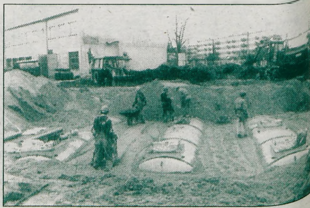
W grudniu w tym miejscu będzie stała nowoczesna stacja
