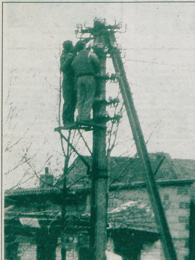
Montaż gniazd w Przykonie
